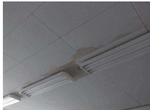
↑天井ボードに見られる漏水の痕跡。各所で確認
