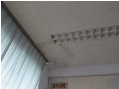
↑天井ボードに見られる漏水の痕跡。各所で確認
