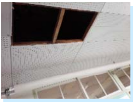
雨漏りによって、 天井が腐食し穴が 開いている
