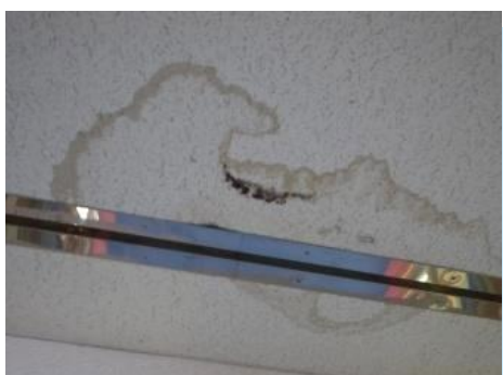
雨漏りによって、天井にシミができています
