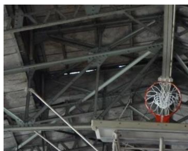
体育館の天井には隙間が… 屋外の光が差し込む
